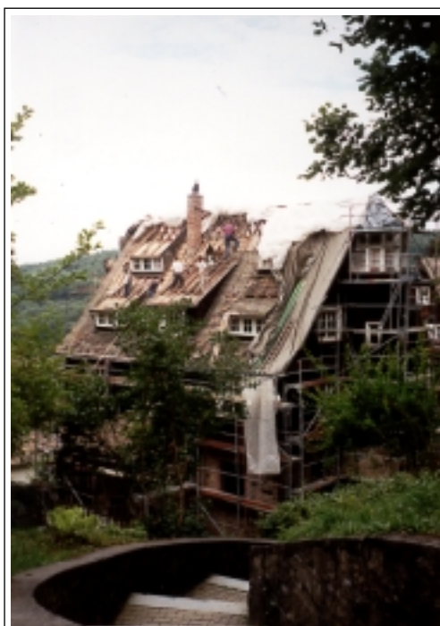
Das Humboldthaus während der Dachsanierungsarbeiten im Sommer '99
